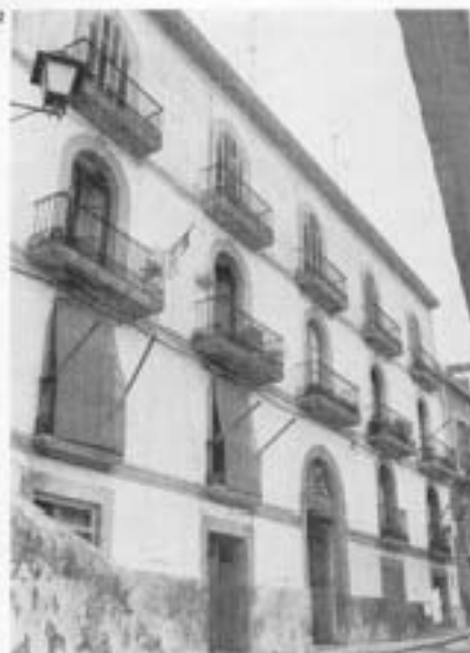
Casa Tuello - Wallis. Calle San Carlos n.º 13. Finales del siglo XIX.
